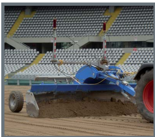
» Stadio delle Alpi — MOBA Dual-Laser-matic im Einsatz bei Planierarbeiten im Fußballstadion des AC Turin (Italien)
