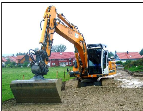
Bagger mit Xsite™ beim Bau der neuen Straße im Neubaugebiet Esele in Apfeldorf
