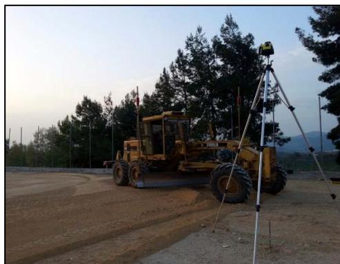
*Als Höhenreferenz für das Nivelliersystem diente das Signal des Dual Slope Lasersenders*
