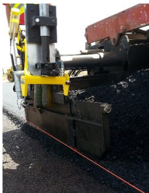
Sowohl ein Seil als auch den Untergrund kann der Ultraschallsensor Sonic-Ski plus als Referenz nutzen
