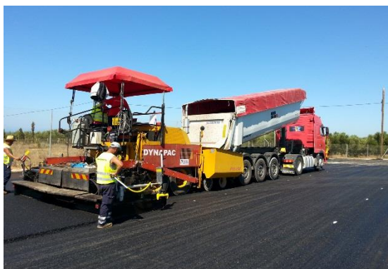
Teststreckenbau in Griechenland mit dem Nivelliersystem MOBA-matic II
