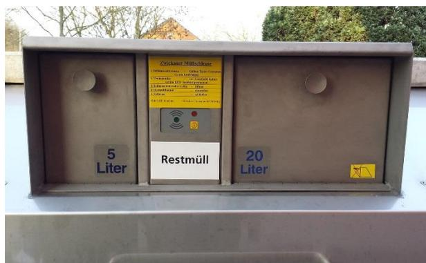
*Müllschleuse mit zwei unterschiedlichen Volumina*
