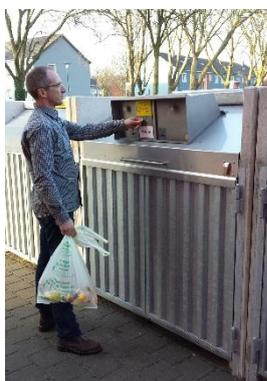
*Benutzung mittels RFID-Chip: Über den Chip wird der Nutzer identifiziert, die Müllschleuse wird geöffnet, der Nutzer kann seinen Müll einwerfen*
